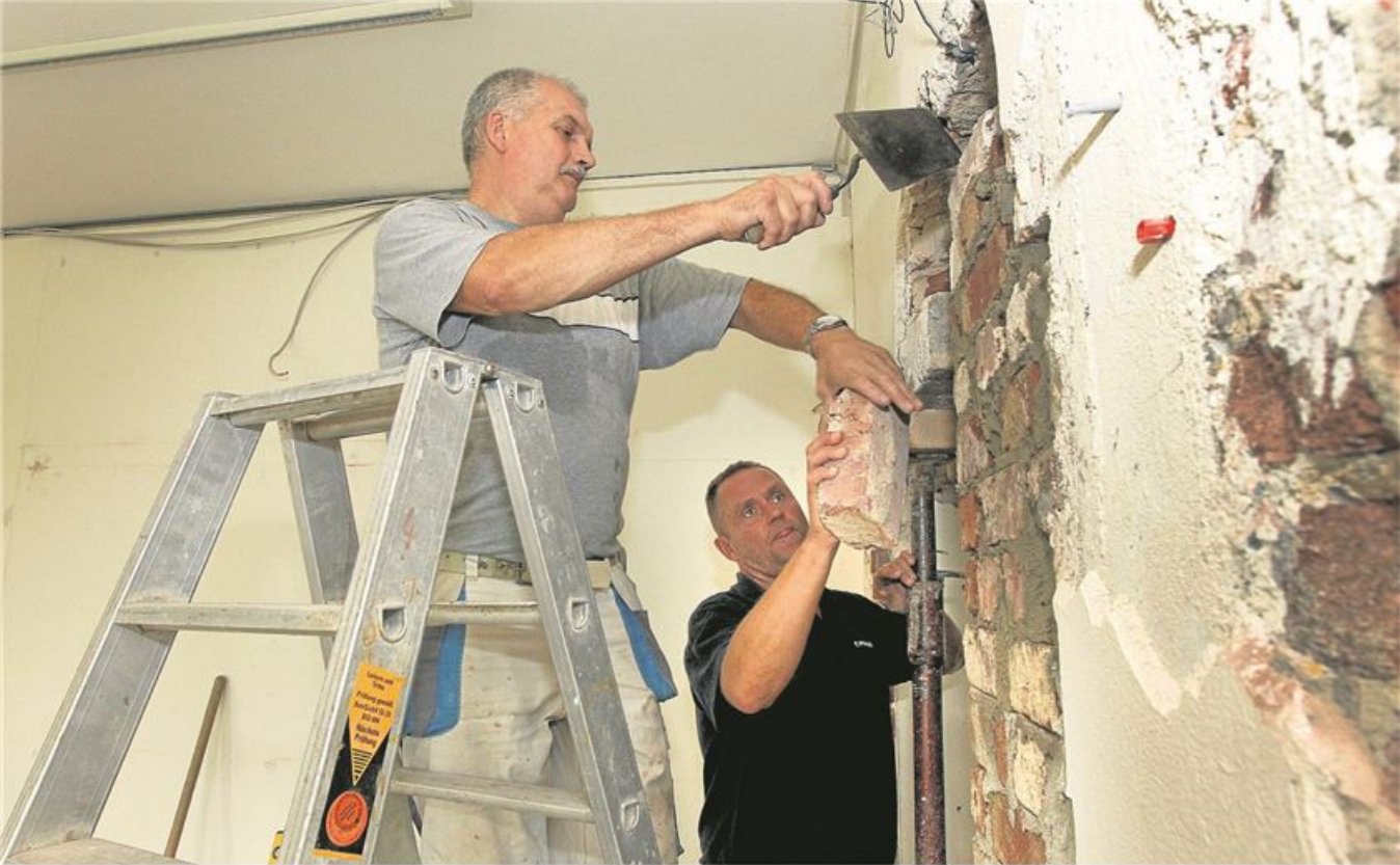
Burkhard Vehring (l.) und Frank Dasbeck vom Baubetriebshof vergrößern zurzeit die Durchgänge im Erdgeschoss des Stadtmuseums in Oberaden.
